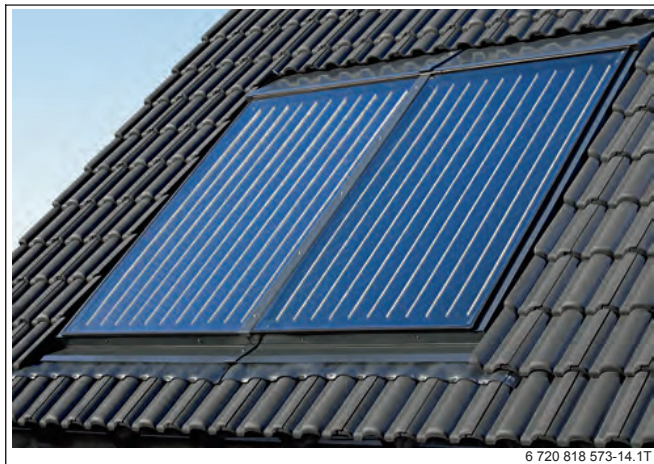
Rys. 177 Widok ogólny pola kolektorów z Logasol SKN4.0-s, montaż w połaci dachu
