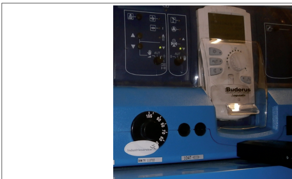
Rys. 7 Prawidłowe ustawienie TR
