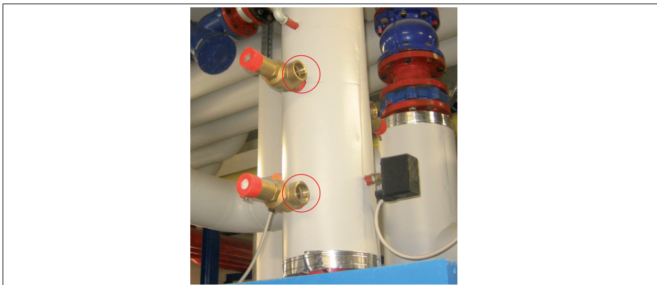
Rys. 15 Brak bezpiecznego wykonania przewodu wydmuchowego
