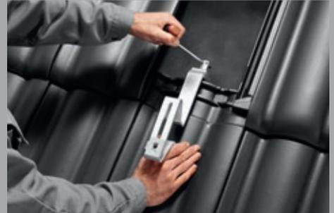
Verstellbarer Dachhaken für die Aufdachmontage.
