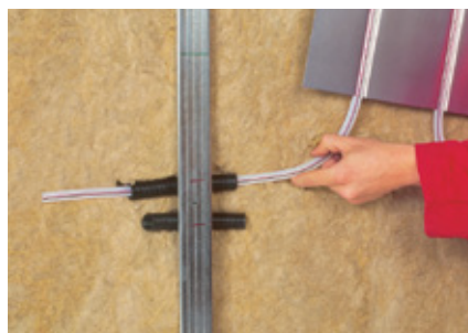
Far passare la tubazione di raccordo
