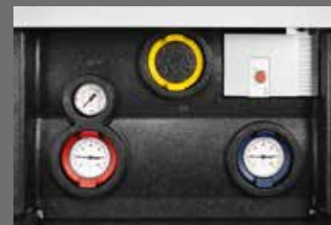
Logamax plus GB162 siurblių grupė
