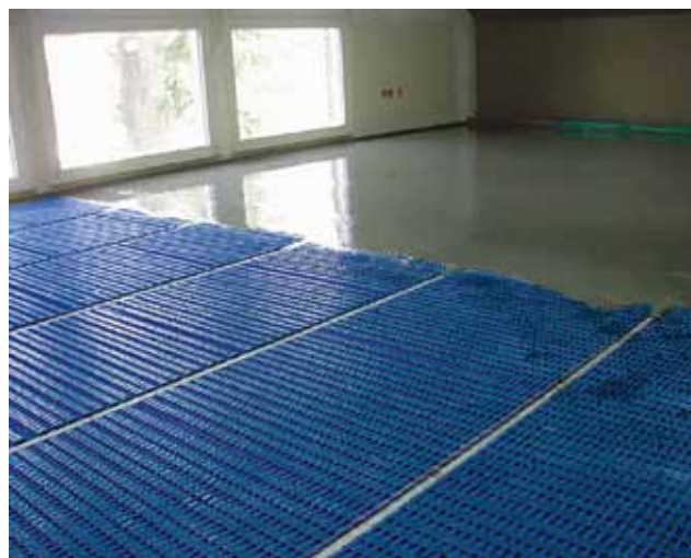
8/1 Installazione Logafix Mat a pavimento
