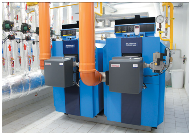
▼ Obr. 3 ● Stacionární kondenzační kotle Logano plus SB625
