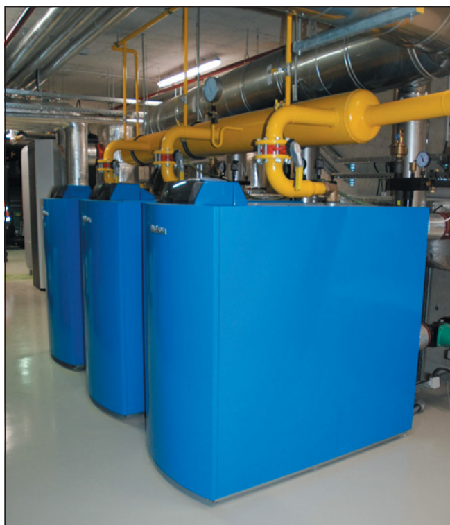
▼ Obr. 2 ● Stacionární kondenzační kotle Logano plus GB402-545
