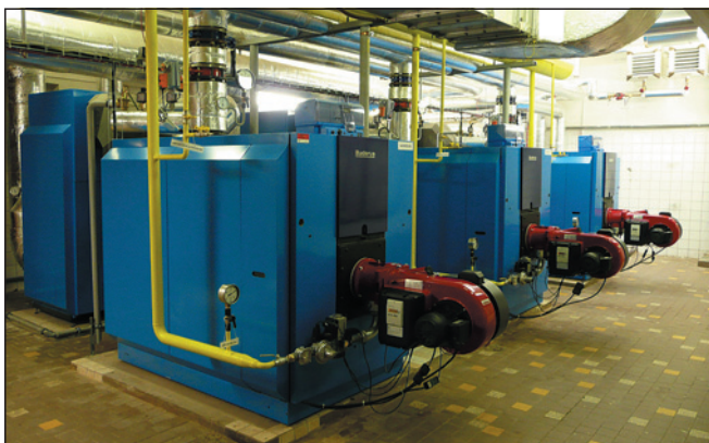
Obr. 1 Kaskádová kotelná s kotli Logano plus GE615
