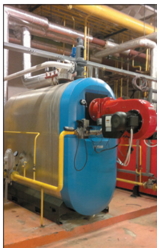
Obr. 1 Kaskádová kotelná s kotli Logano plus GE615
