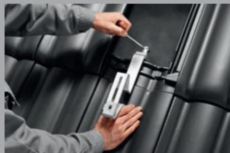
Ganci per tetto regolabili per il montaggio sopra tetto.
